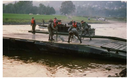
Verbinden der Rampen und Mittelteile
