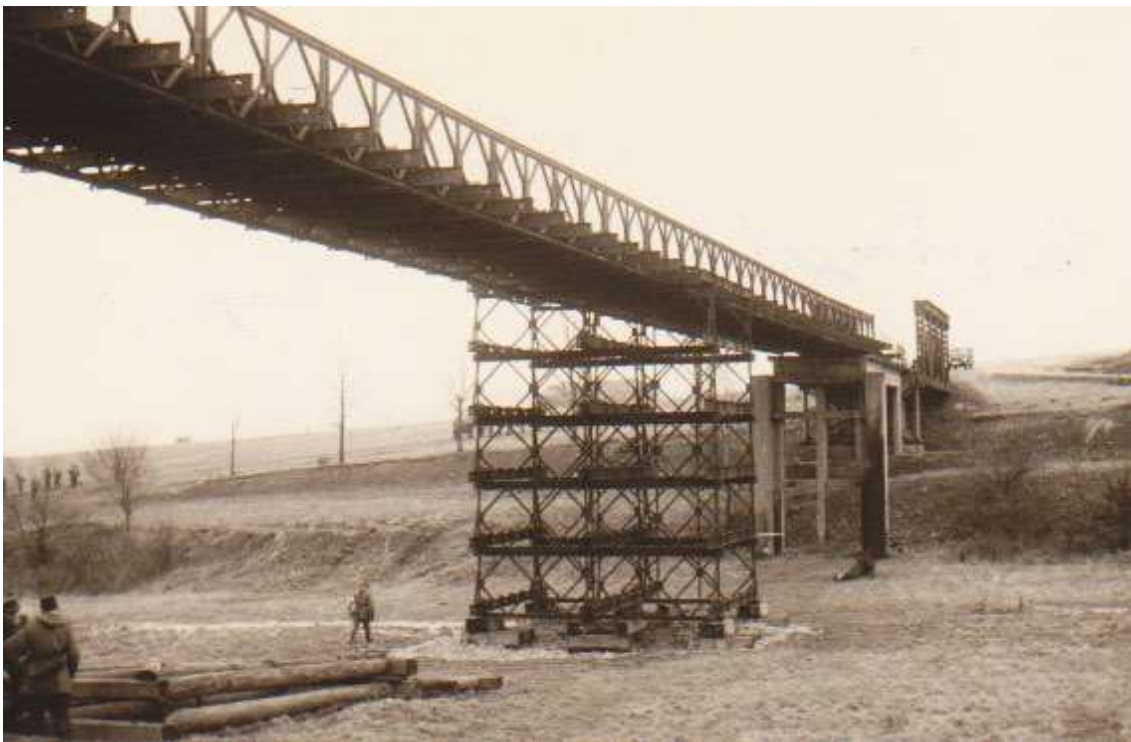
Ausbildung, Bau einer Bailey Bridge
