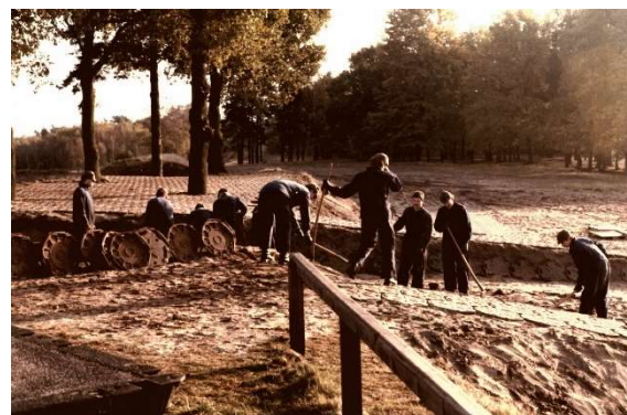
Verlegen von über 500.000 Sechseckplatten
