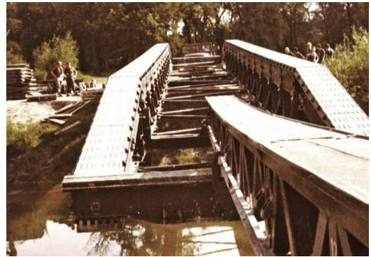
Bau der MGB über einen Fluss
