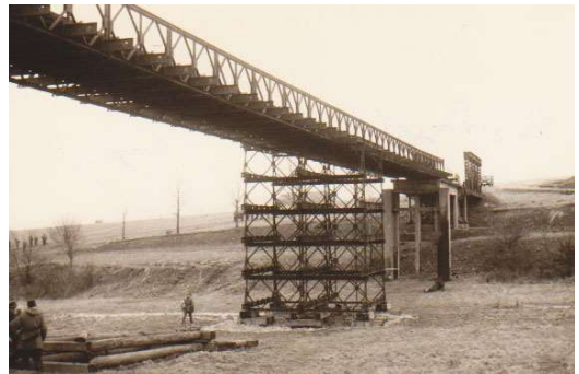
Fertigstellung der Baily Bridge auf dem LÜP
