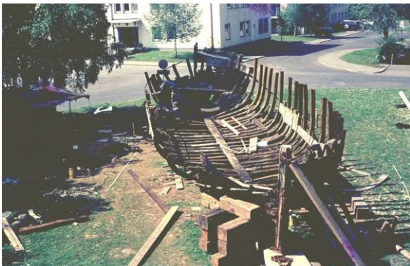
Das Balkengerüst ist fast komplett wieder hergestellt
