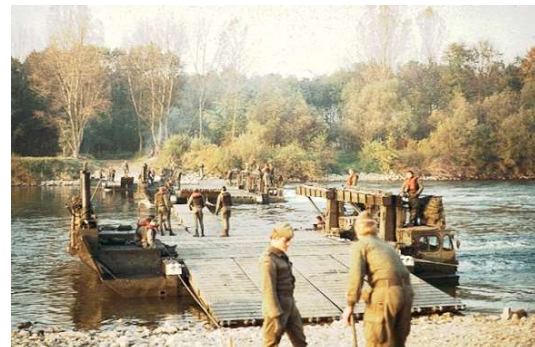
Schließen der Brücke
