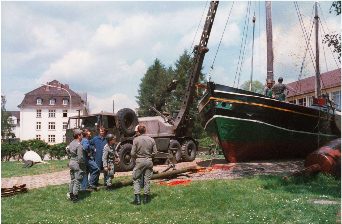
Setzen den zweiten Segelmasten
