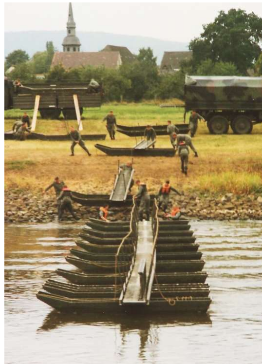
Bau und Verbinden Schwimmsteg
