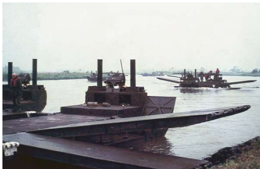
Einschwimmen zum Schließen der Brücke
