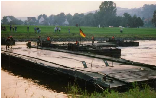
Verbinden der Brückenabschnitte FSB
