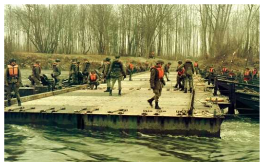
Verbinden und Fertigstellung der Brücke
