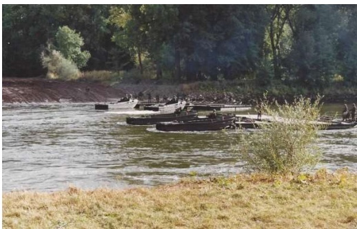
Einschwimmen Hohlplattensegmente
