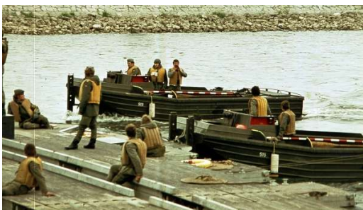
Zusammenfügen der SSB Segmente
