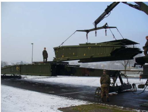
Auffahrrampe wird gesetzt
