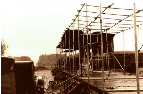
Tribünenbau aus Rohrbaugerüst und Hohlplattensegmenten
